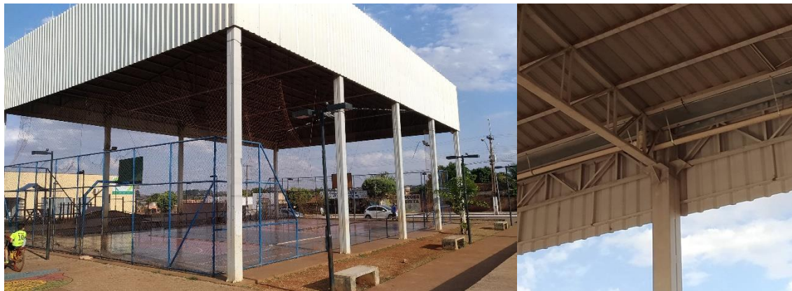
Figura 6. Cobertura da quadra do Céu Azul, (a) vista lateral da cobertura; (b) vista do apoio da treliça no pilar. Fonte: Autor
